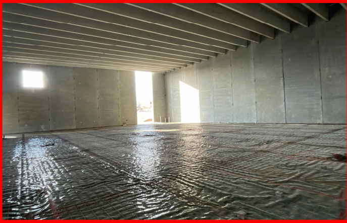
Gym Slab Prepped and Ready to Pour
